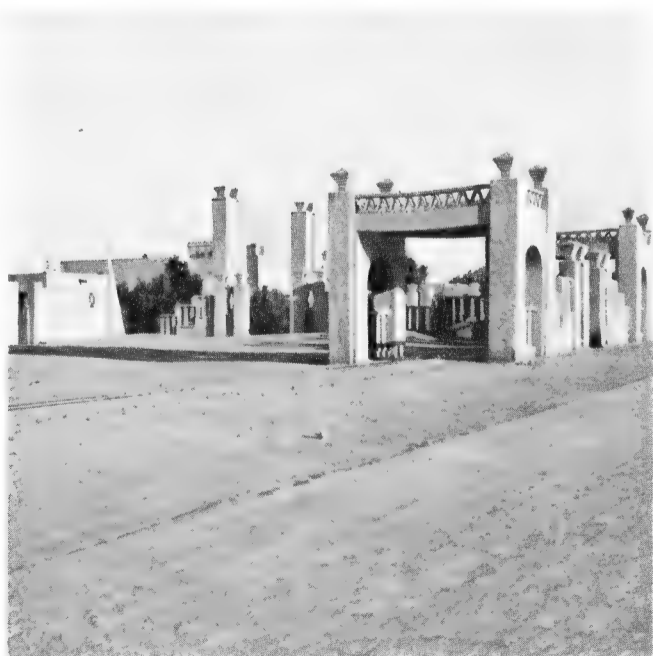
Portiques à Ouargla.
